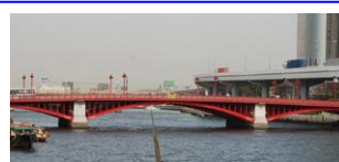
吾妻橋（昭和 2 年 竣工）
