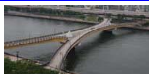
桜橋（歩行者専用道 昭和 60 年 竣工）
