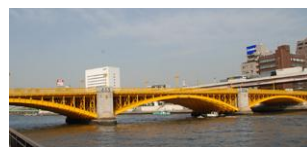
蔵前橋（昭和 2 年 竣工）
