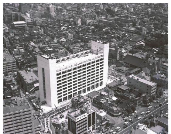
本庁舎落成（昭和 48 年 8 月）
