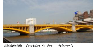
蔵前橋（昭和 2 年 竣工）
