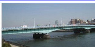
言問橋（昭和 3 年 竣工）
