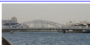
白鬚橋（大正 3 年 竣工）
