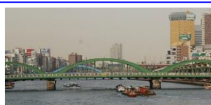
厩橋（明治 7 年 竣工）
