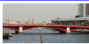
吾妻橋（昭和 2 年 竣工）
