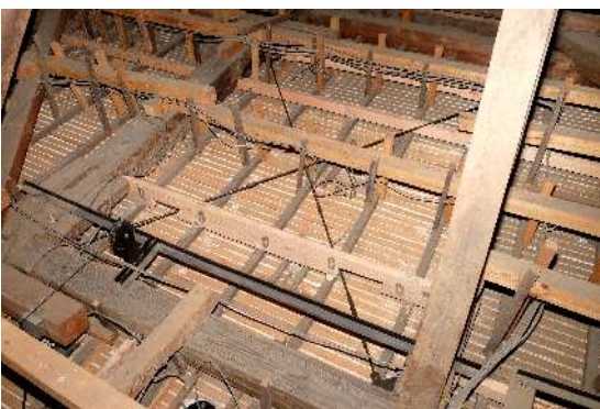
耐震性を高めるため鉄筋ブレースを設置した。
