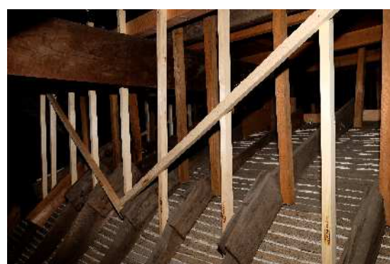
吊木を追加し、さらに振れ止め用の斜材を取り付けた。
