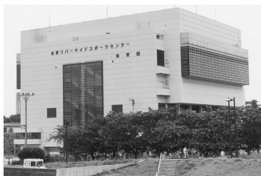
台東河边体育中心 台東リバーサイドスポーツセンター
