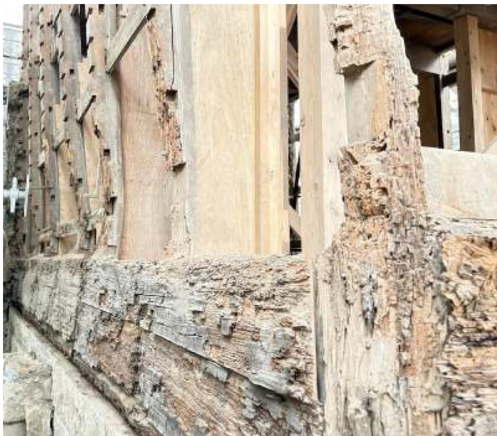
すぺーす小倉屋 蔵 外壁解体後の土台・柱写真
