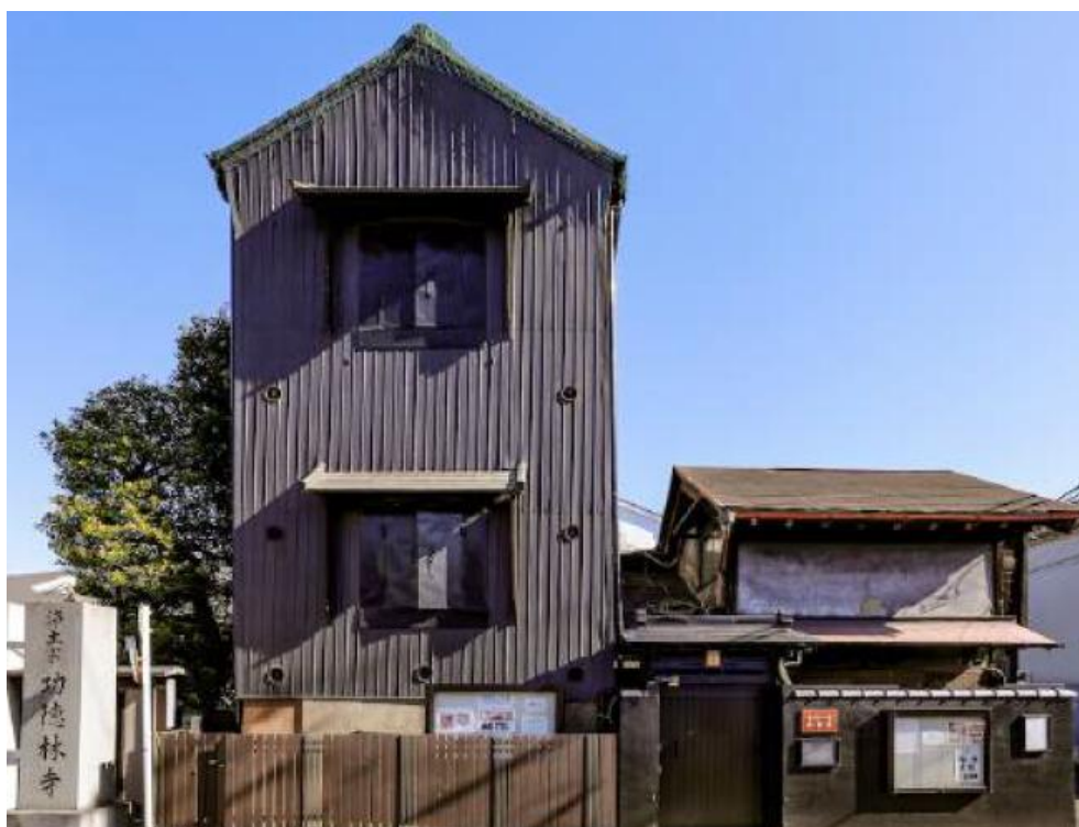
すぺーす小倉屋 改修前写真
