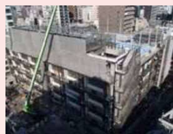
建設中の新校舎
