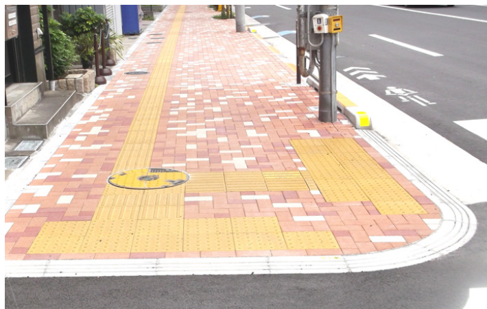
【バリアフリー化された歩道の例】
