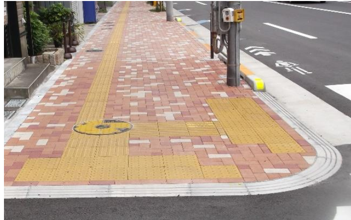
【バリアフリー化された歩道の例】
