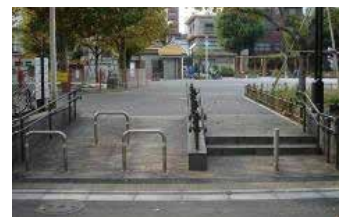
公園出入口(スロープ)
