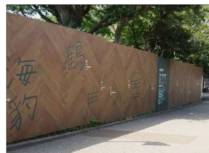
周辺や施設の雰囲気に配慮した仮囲いの例
