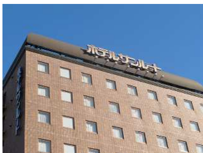
屋上広告板を建物屋根状のデザインとし、切り文字として、周辺のまち並みに配慮した例
