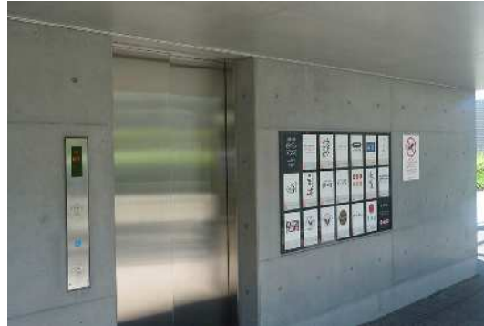
壁面の目地をガイドとして各要素が整然と配置されるよう、集約看板もこれに合わせてデザインされています。
