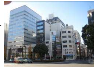
春日通りより南側では低層部では設置されているが、中高層部での設置はほとんど見られない
