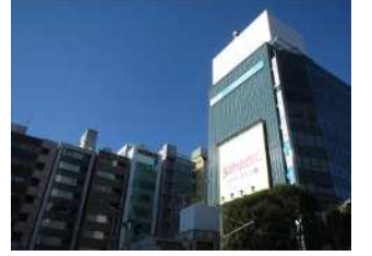
上野広小路会館に設置されている大規模な壁面広告
