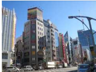
繰り返し表示のあるカラオケ店や様々な屋外広告物が設置されているビル
