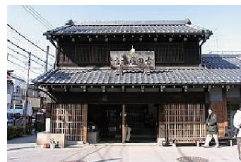
▲ 旧吉田屋商店 (移築保全し公開中)
