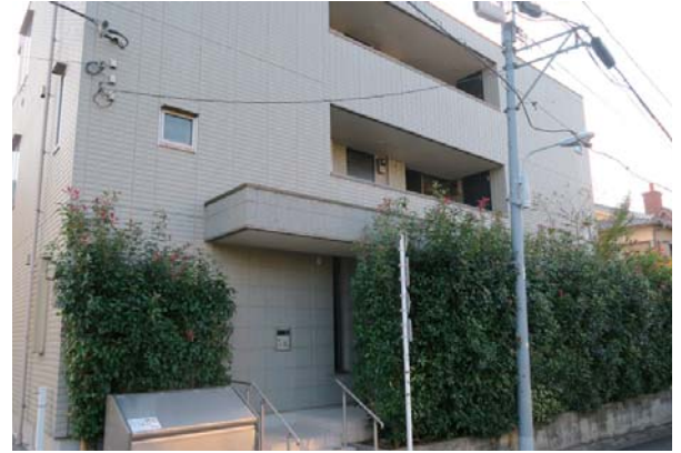
階段を内部に設け、通りに対して緑化された共同住宅
