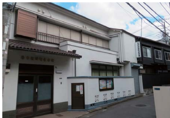
低層・勾配屋根の建物
