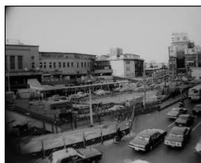
新幹線の建設 (出典：台東区立中央図書館所蔵高相嘉男コレクション)
