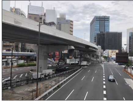
首都高速1号上野線と昭和通り
