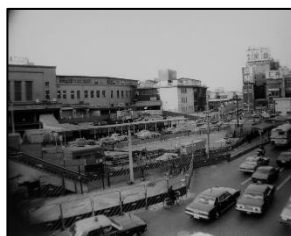
新幹線の建設 (出典：台東区立中央図書館所蔵 高相嘉男コレクション)
