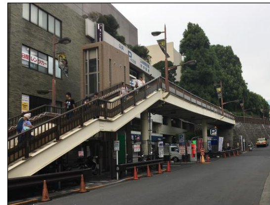
【上野公園の崖線】 ・観光客の多い上野公園との間には、約20mほどの段差が生じている
