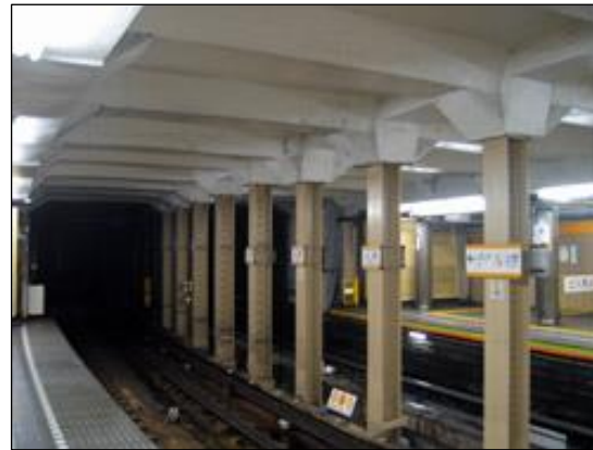
銀座線上野駅の鉄鋼框(かまち)構造 日本土木学会の認定する土木遺産に選定されている(東京メトロHPより)
