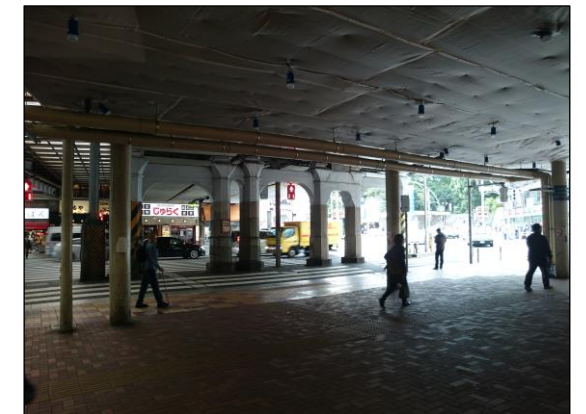
【上野駅不忍口】 ・駅出口付近に鉄道の高架があり、視認性が悪い
