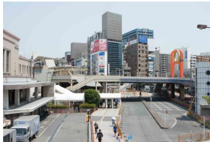
上野駅駅舎と交通広場
