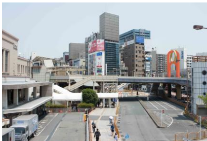
上野駅駅舎と交通広場
