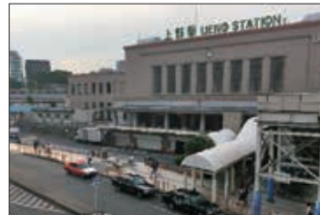
・JR 上野駅正面口 駅業務施設・商業施設の荷捌き等が行われている
