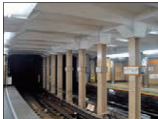
・銀座線上野駅の鉄鋼框 (かまち) 構造 日本土木学会の認定する土木遺産に選定されている (東京メトロ HP より)
