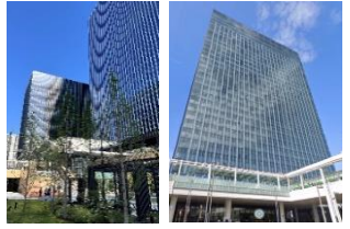
背景の空と調和した建物ファサード
