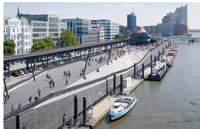
川と街の間に壁がなく、堤内に駐車場等が整備されている堤防例（ドイツ北部エルベ川河口）
