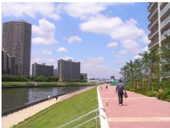
スーパー堤防の整備例（千住大橋）
