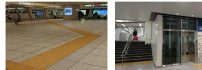
点字ブロック整備
