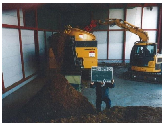
搬出した被害木のチップ化作業
