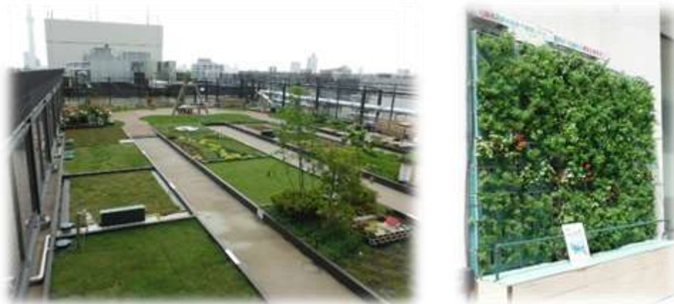
台東区役所の屋上緑化(左)と壁面緑化(右)
