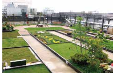
区役所の屋上緑化
