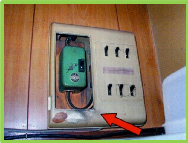
配電盤からも出入りします。左上写真の左下の汚れがラットサインです。配電盤のカバーをはずすと、右上写真の電線の挿入部分にすき間がみえます。
