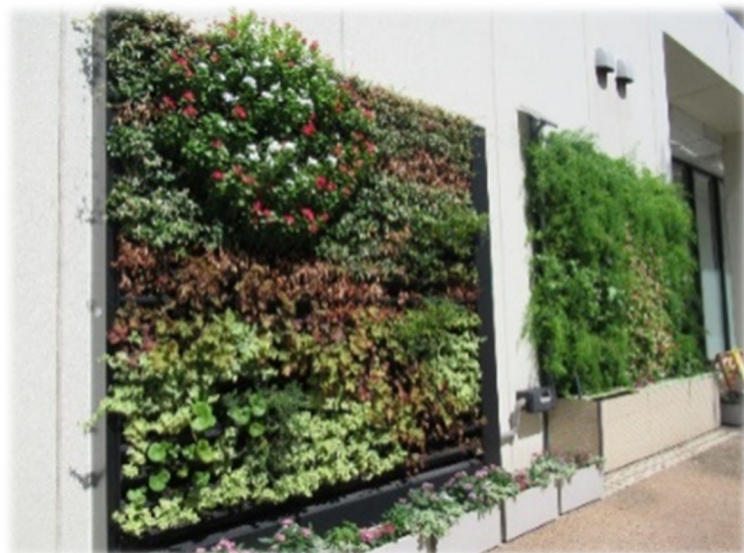
台東区役所本庁舎壁面緑化モデル展示
