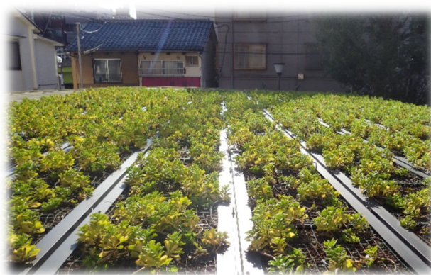
根岸こどもクラブ屋上緑化
