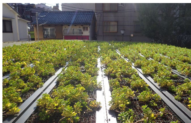
根岸こどもクラブ屋上緑化
