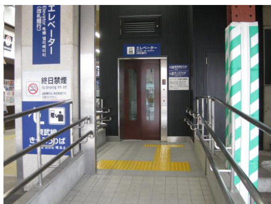
※東武浅草駅エレベーター
