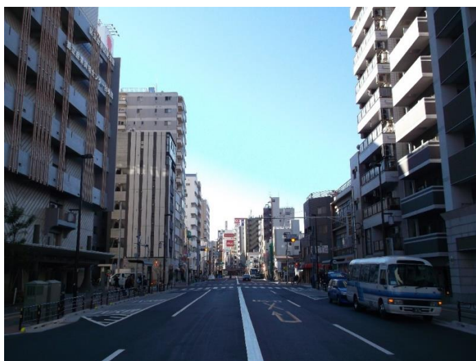
台東区内の無電柱化された道路
