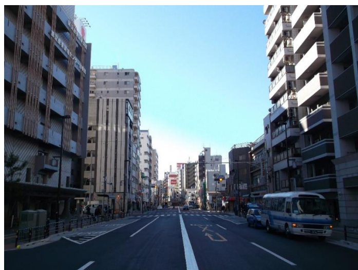
台東区内の無電柱化された道路
